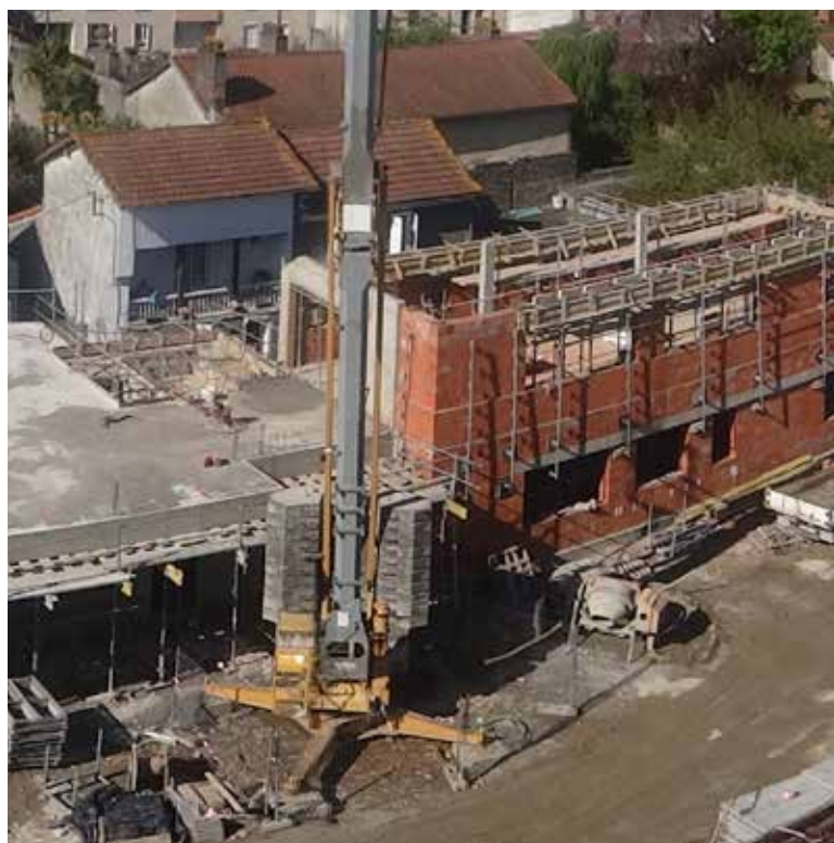
▲ Construction de la Maison de santé pluriprofessionnelle de Vic en bigorre
